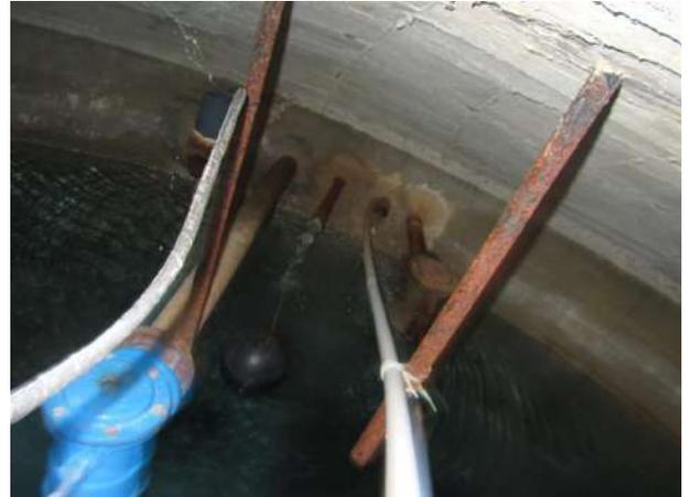
*Cuve, échelle et flotteurs sur les arrivées des ressources*
